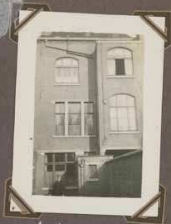
ARRIÈRE DU FOYER
