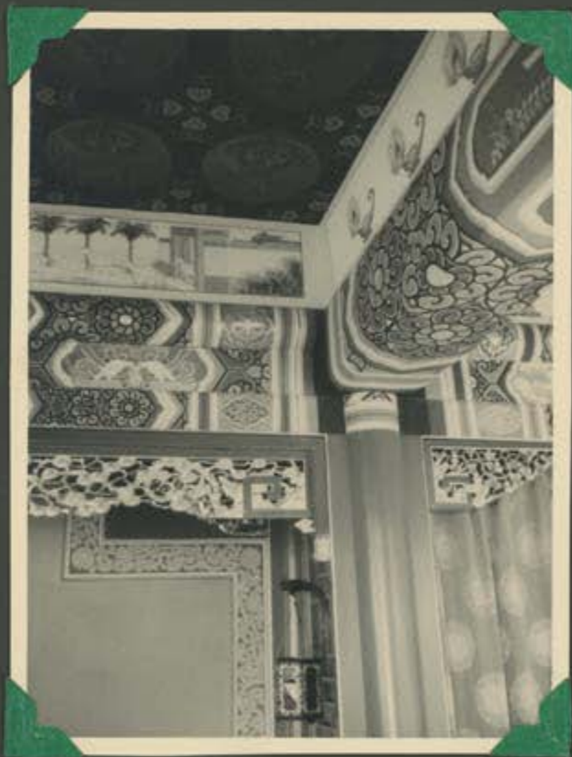
Jonction de poutre, traverses et colonne.
