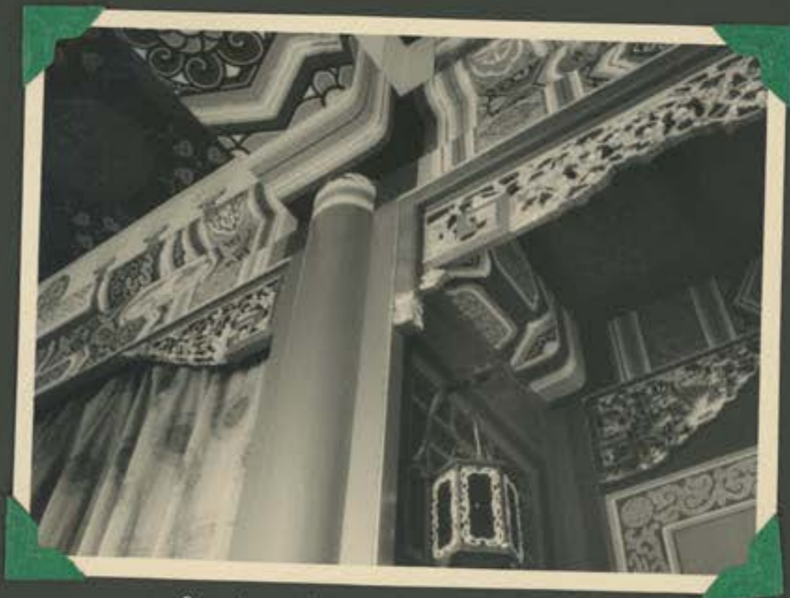
Enchevêtrement de poutres.
