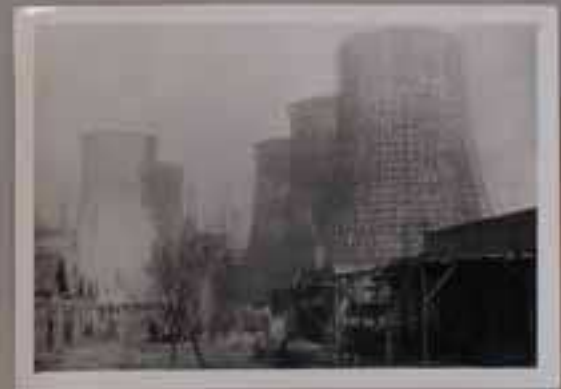
Centrale électrique de Fushun 7 Mars 1948
