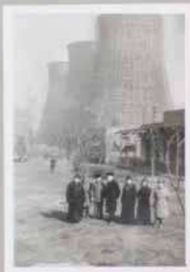
Centrale électrique à Fushun, P. R. Ch.
